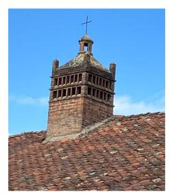
Sur la toiture en tuiles creuses, on remarque une sorte de minaret carré, ajouré en briques surmonté d'une fine croix en fer. Cet édifice ou **mitre** est la partie extérieure d'un système de chauffage particulier à la Bresse appelé « **cheminée sarrasine** », la partie intérieure ou **hotte**, vaste entonnoir de 3-4 m de côté et 5-6 m de haut, correspond à un « foyer chauffant au large » (foyer dont on peut faire le tour).
